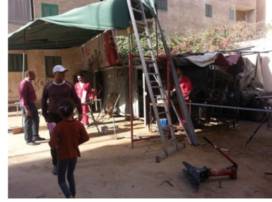
صورة رقم ٣:أعمال التجهيزات داخل مناطق العمل
