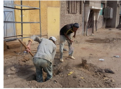
صورة رقم ٥:الحفر الاستكشافية
