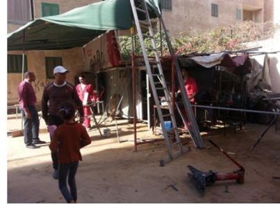
صورة رقم ٣:أعمال التجهيزات داخل مناطق العمل
