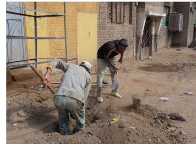
صورة رقم ٥: الحفر الاستكشافية
