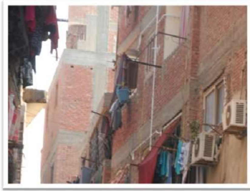
شكل رقم 4-7: نموذج لأحد المباني المشيدة من الطوب الأحمر في مدينة الخصوص
